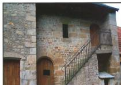
L'ancien manoir de la Braise en cours de rénovation.
